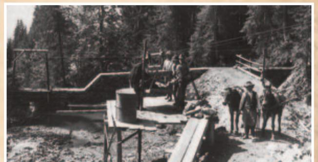
**Dieses Bild aus dem Jahre 1953 zeigt eine Partie von Arbeitern beim Verbau des Lauterbaches zwischen Ahornau und Buchau. Rechts erkennen wir den Frankbauern, der mit seinen Maultieren (Muli) für den Materialtransport zusätzlich zur Seilbahn sorgte.**
