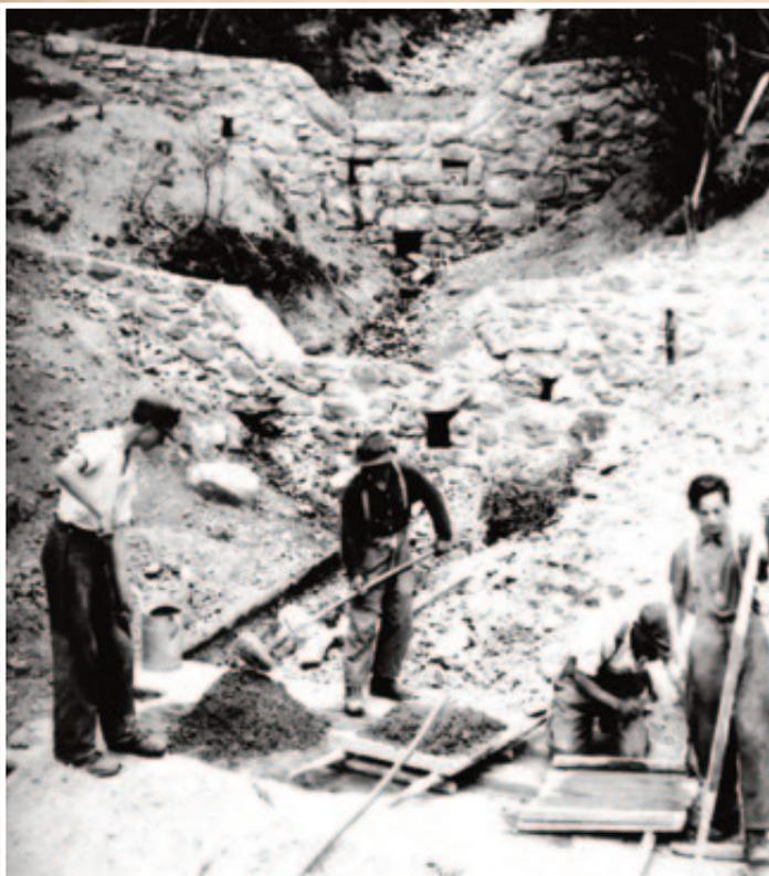
**Dieses Foto entstand vor genau 70 Jahren beim Bau der Sperren im „Bergergraben“. Das ist der Bach westlich vom Hof Vorderberg, der durch das Dorfzentrum (Brixnerwirthöhe) und unter der Bahnlinie zur Brixentaler Ache verläuft. Die Arbeiter mussten auf dieser Baustelle den Beton noch mit der Hand mischen.**
